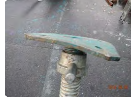
プレート部分の曲り、変形
