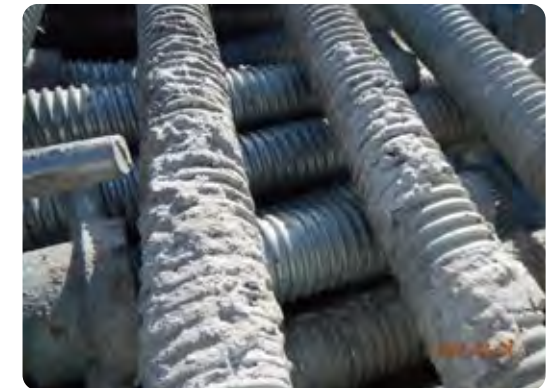
ネジ管部分のコンクリート付着
