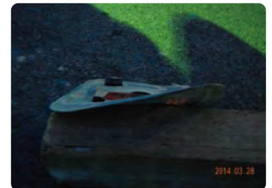
全体の曲り、変形
